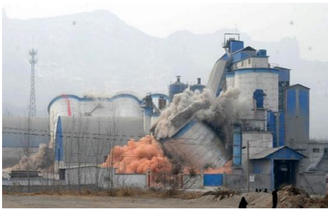
Ảnh 3: Nhà máy xi măng công nghệ cũ bị phá dỡ tại Trung Quốc
